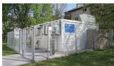
■(左)ハイブリッド蓄電設備 技術レポート「再生可能エネルギーの自家消費型システムのNEDOドイツ実証」(P.13)
