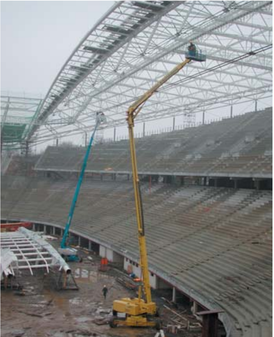
Bild 5-1: Hubarbeitsbühne im Baustelleneinsatz
