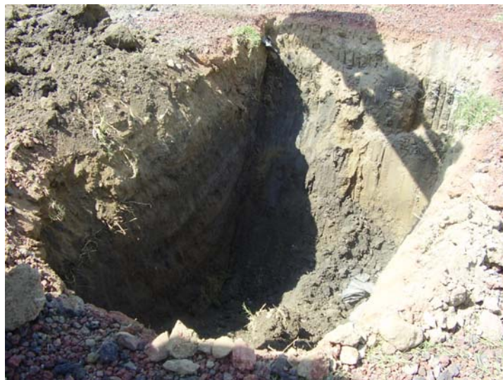
Figura 3.4. Excavación de pozos a cielo abierto.
