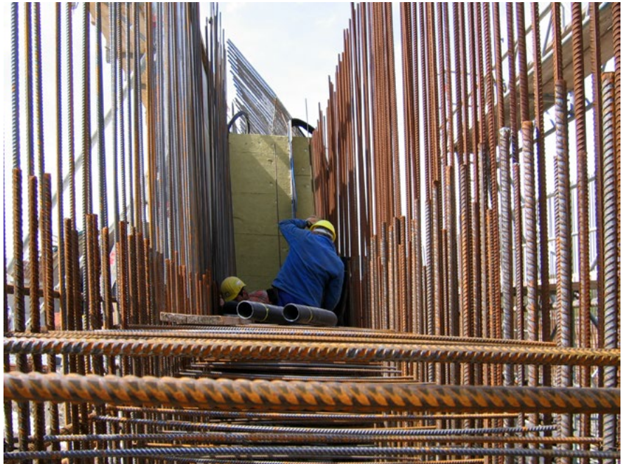
Abb. 19 Beispiel für erhöhte elektrische Gefährdung
