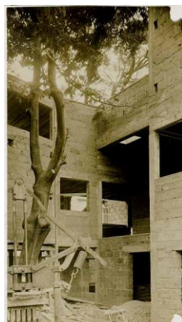
Chantier Maison La Roche, Hall et grande baie 1924 (FLC L2-12-22) (FLC L2-12-18)
