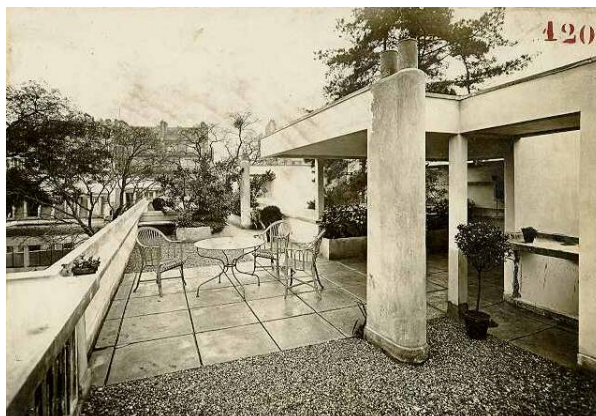
Vue du toit-terrace de la Maison La Roche et Jeanneret au fond. Etat d'origine L2 (12) 55
