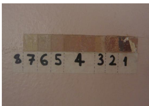
Sondage de chromie réalisé au cours de la restauration des intérieurs de la Maison La Roche en 2009 – Salle à manger
