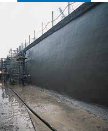
Canale idroelettrico Bertini - Robbiate (CO): vista d'assieme
