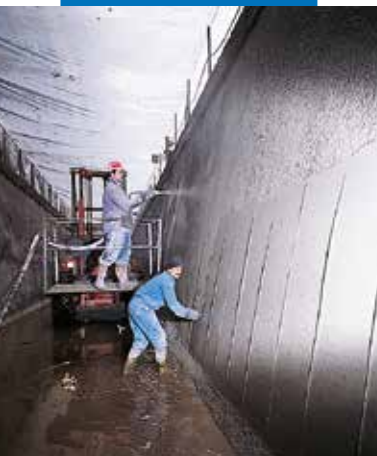
Canale idroelettrico Bertini - Robbiate (CO): rifinitura con spatola
