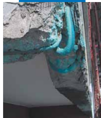
Ferri di armatura del frontalino di un balcone trattati con Mapefer 1K
