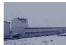
Usine de Kalekim, Erzurum
