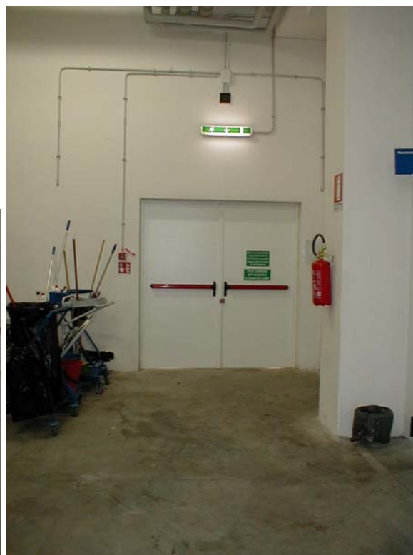
Vie d'emergenza sgombre da materiali
