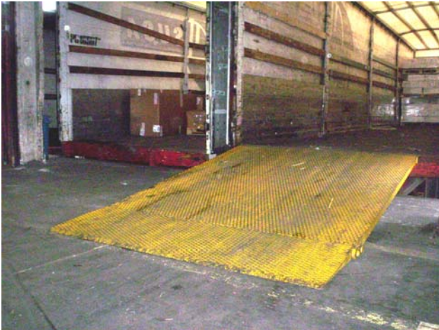
Rampa di carico manuale non fissata
