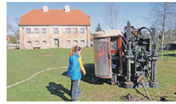
Baustellenberatung vor Ort in Groß Döbbern. (Fotos (3): LWG/Röwer)
