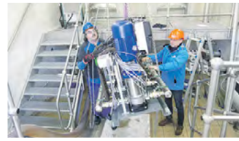
Einbau der neuen Reinwasserpumpenanlage im Wasserwerk Halbe.
