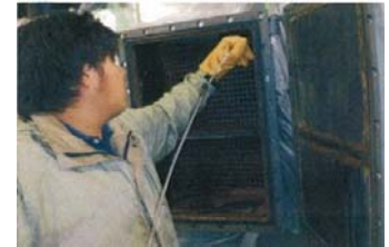
▲冷温水発生機熱交換器チューブの薬品洗浄
