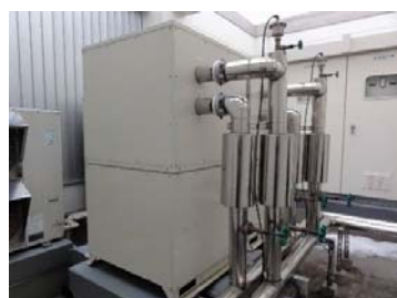
▲地中熱ビル用マルチヒートポンプ屋外機
