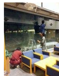
▲ロビー南東ガラス面のコート剤塗布
