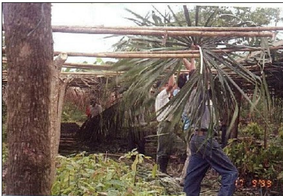
CONSTRUCCION DE TINGLADO
