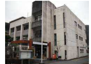
老朽化した公共施設
