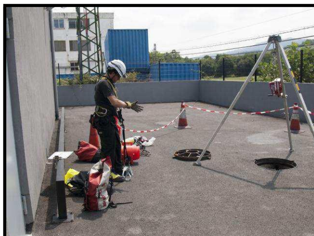
Entrada a un recinto confinado balizado y con el material lejos de la boca de entrada
