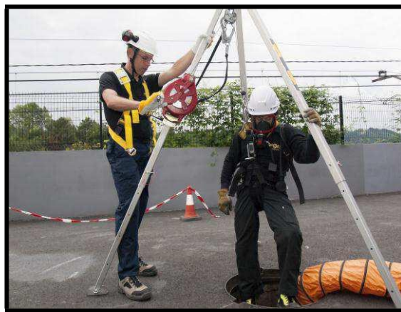
Utilización de un equipo de protección respiratoria para realizar la entrada en un pozo
