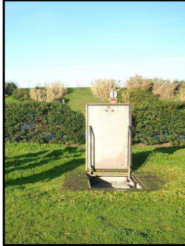
Acceso a un pozo
