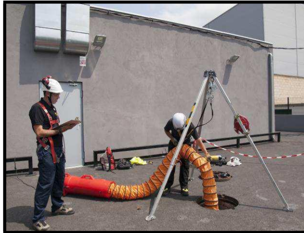
Instalación de un sistema de ventilación
