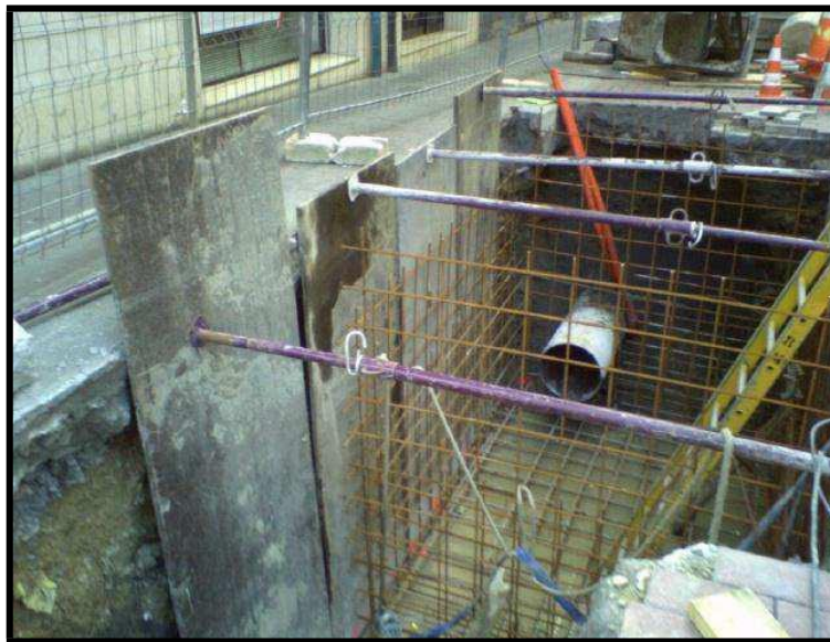
Entibación con planchas de metal
