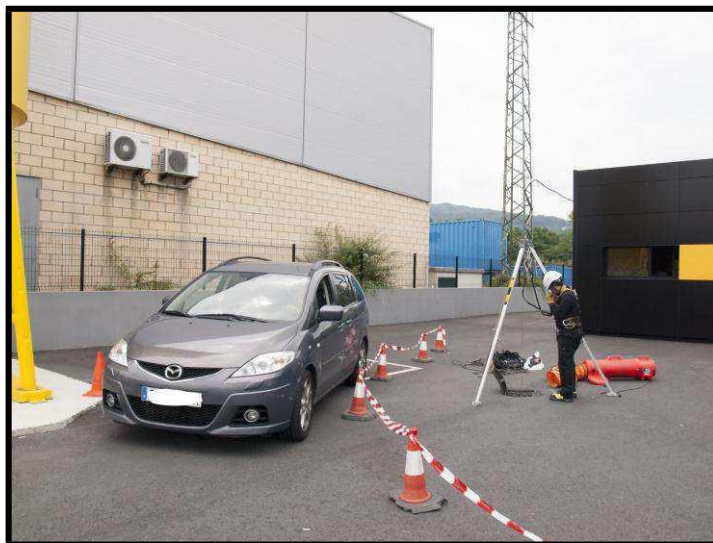
Control y desvío del tráfico rodado junto a un recinto confinado
