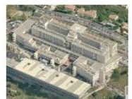
FIG. 1.3. CHANTIERS REALISES PAR B.A.B.E.T.
