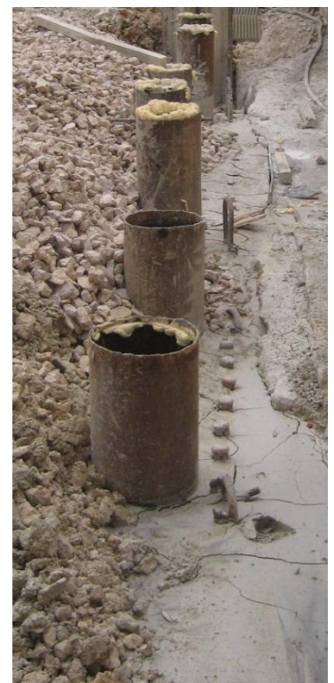
Fig. 2.2.3. Paroi moulée amont
