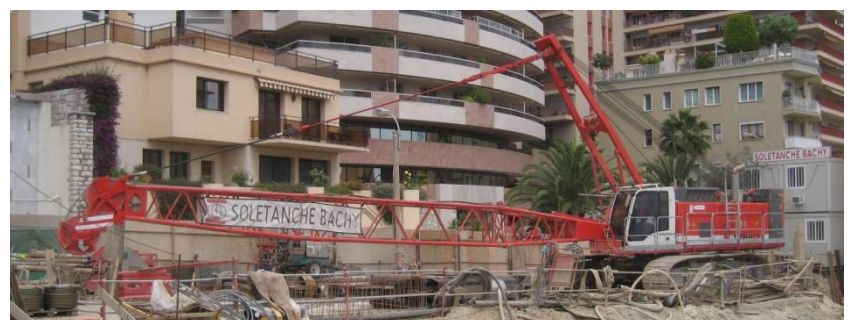
Fig. 2.2.5. Machine posant les armatures
