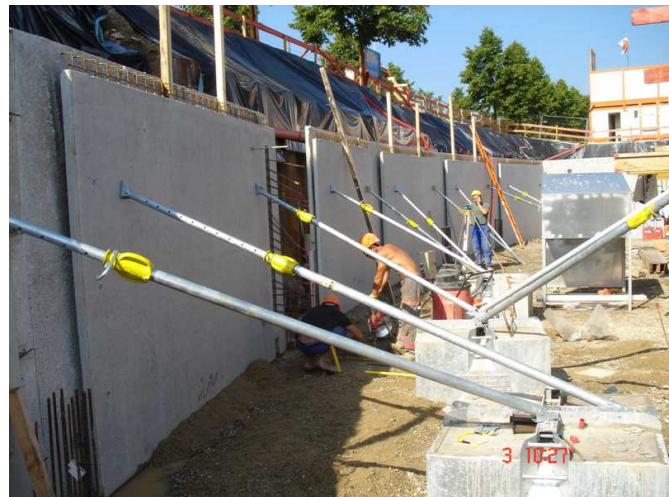
Figure 17 – Pose et stabilité d'un prémur
