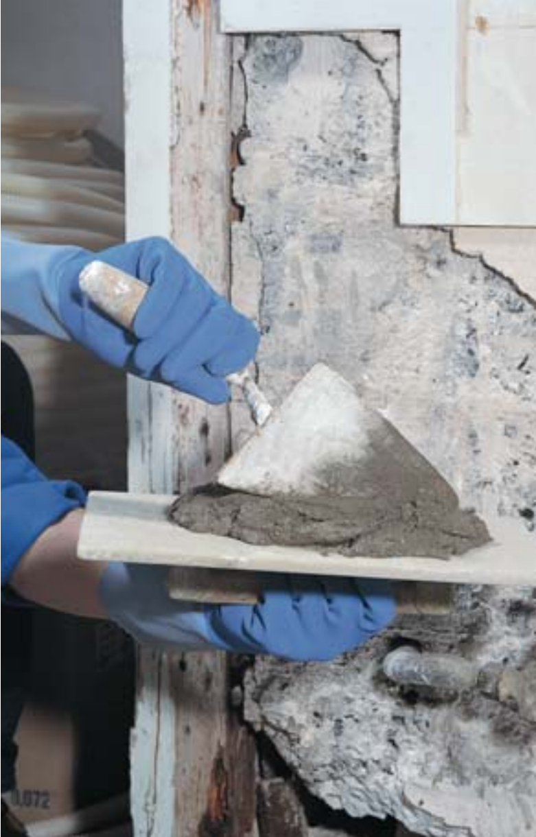
Abb. 1: Wer öfters und länger in feuchtem Milieu arbeitet, sollte flüssigkeitsdichte Handschuhe tragen. Allergien, die durch „Gummihandschuhe“ hervorgerufen werden, sind aber heutzutage relativ selten.
