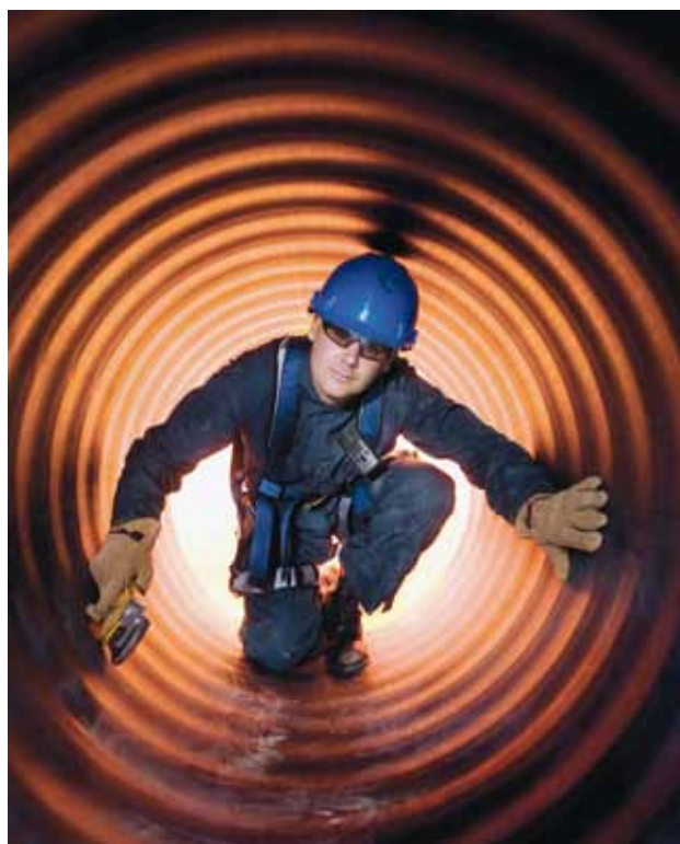
28 Utilizzo di un rilevatore di gas in un ambiente ristretto
