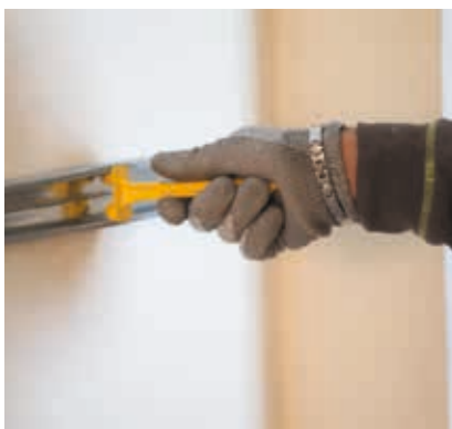
Étape pose des tiges d' Appui Optima 2 sur la fourrure horizontale murale Fourrure Optima
