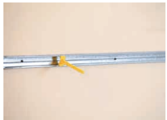
Étape pose des tiges d' Appui Optima 2 sur la fourrure horizontale murale Fourrure Optima
