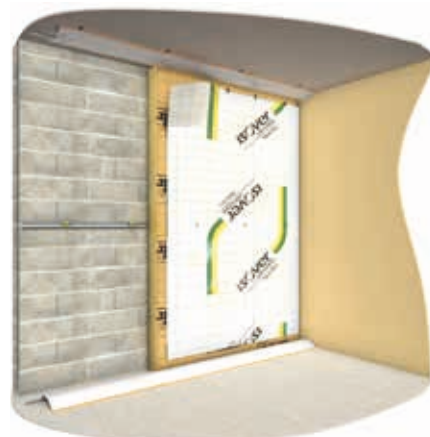
Mise en place des lés de membrane Vario® Xtra
