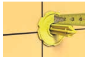
Première étape de l'étanchéité à l'air au niveau de chaque appui Optima: mise en place de la rondelle de la pastille Optima 2
