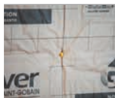
Embrochage de l'isolant GR 32 sur la tige de l' Appui Optima 2
