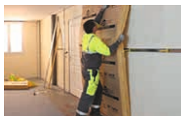
Mise en œuvre de l'isolant GR32 et embrochage sur les tiges d' Appuis Optima 2
