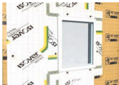
Liaison de la bande de membrane Vario® Xtra avec Vario® Xtra Band en entourant de fenêtre
