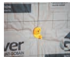
Verrouillage provisoire de la clé d' Appui Optima 2 par rotation quart de tour
